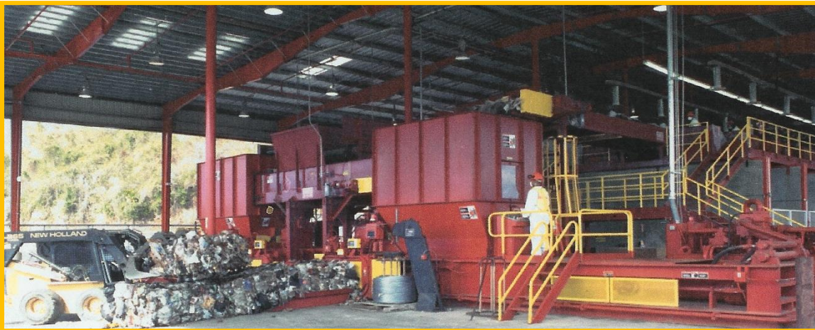
Imagen No. VI.3.6.3.3 Planta de compactación de CDR, Alcaldía Iztapalapa, CDMX.
