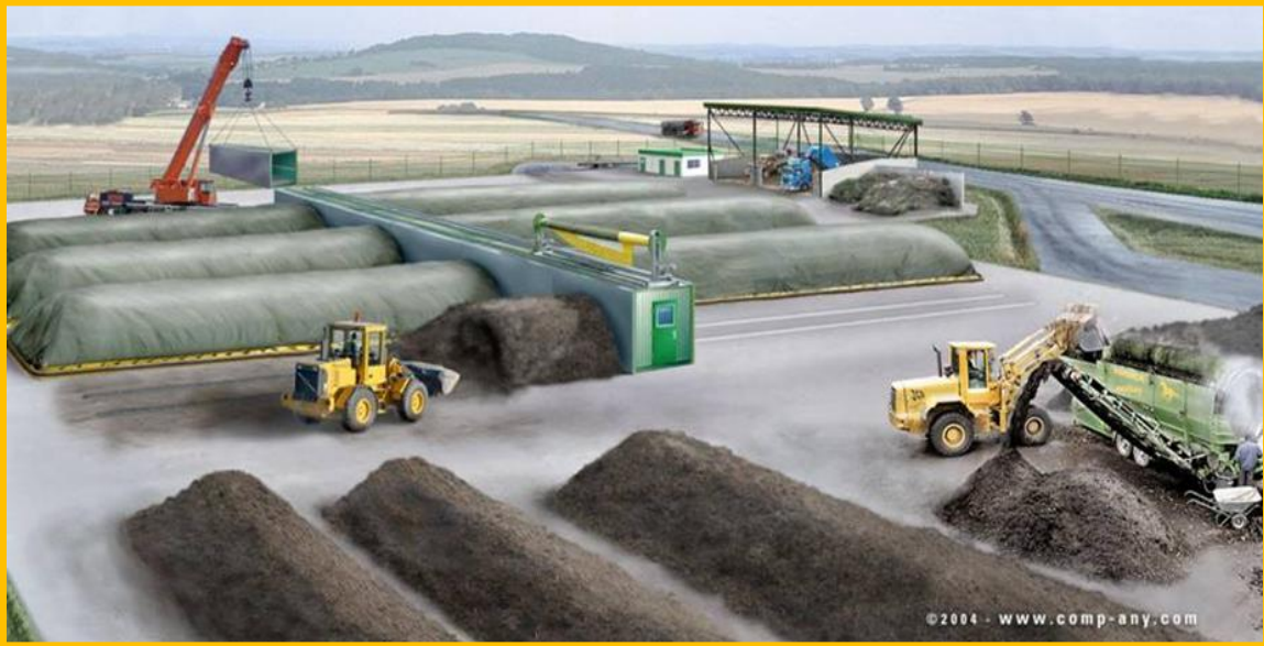
Imagen No. VI.3.6.3.2 Planta de generación de composta.
